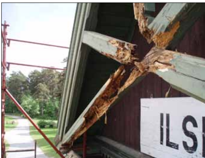
Det var høyst påkrevet at mønekryssene på Ilseng ble restaurert. Slik så det ut da det råtne treverket var fjernet. Til høyre er sommeransatte Sara Gundhus Bø i sving med å restaurere riksvåpenet på en oppslagstavle på Ilseng. Øystein Bø
