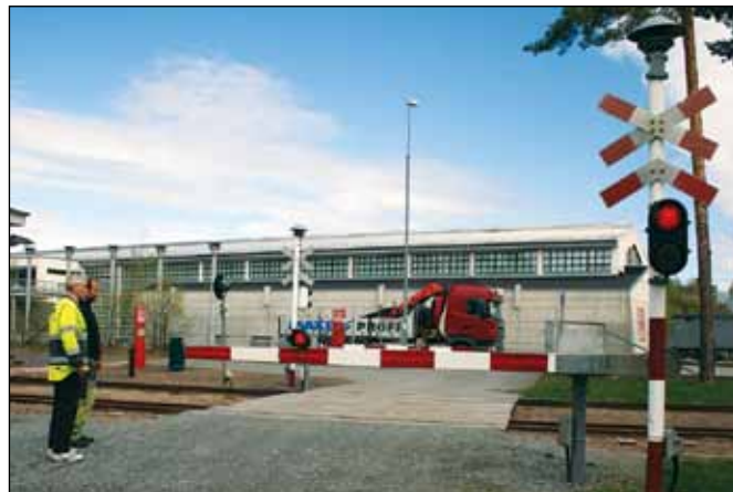
Det ble i mai tatt i bruk et halvbananlegg på Tertittsporet. Anlegget er satt i drift av JBV Signal, Hamar.
