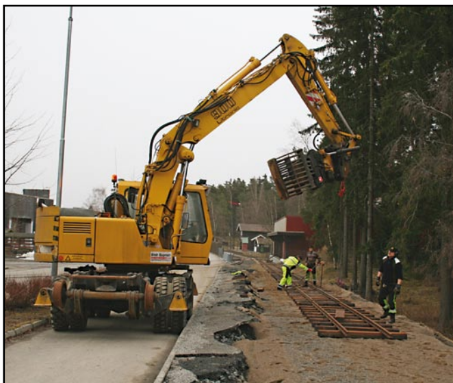
Tertittbanens forlengelse. Over heises ferdige sporstiger på plass ved hjelp av gravemaskin. Bilder fra april 2008. Thor Bjerke, NJM (begge)
