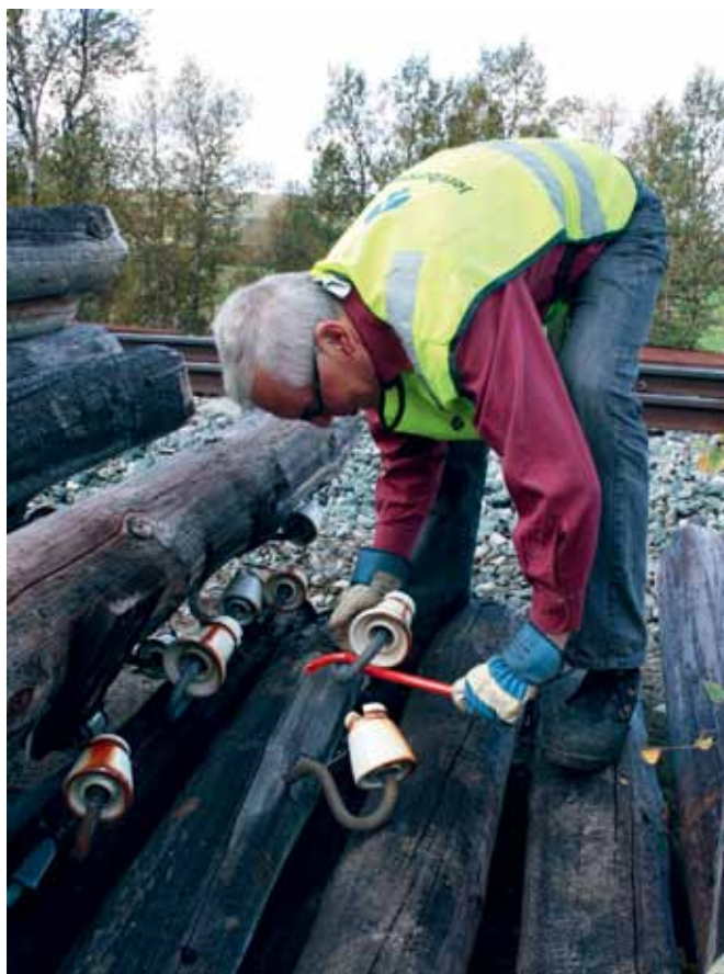
Det skal settes opp en telefonkurs på museet. Porselensisolatorer hentet vi hos JBV på Røros. Det er Svein Krogrud som er i ferd med å skru av isolatorer.
